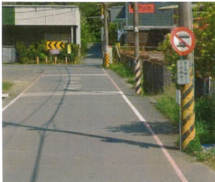
圖 1 現場掛設禁止標誌
