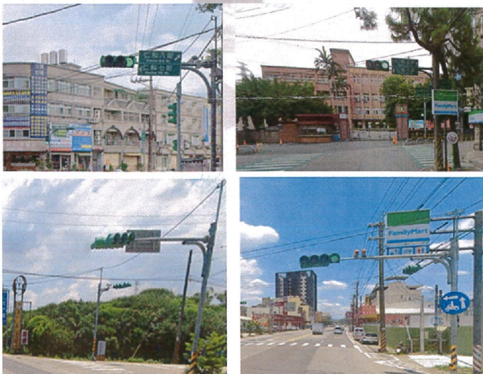
圖 1 本案現場無掛設禁止牌面
