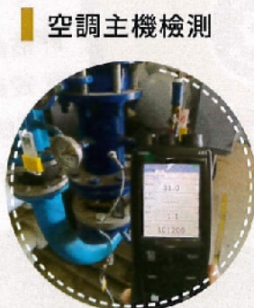
設備機房溫度檢測
